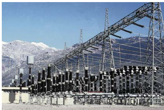
Κέντρο Υπερυψηλής Τάσης 400/150 kV
