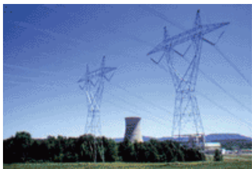
Γραμμή μεταφοράς 400 kV
