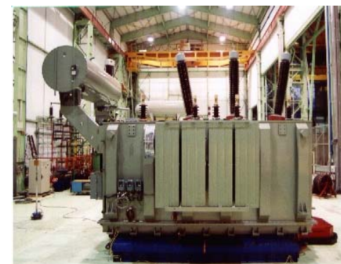
Μετασχηματιστής 150/21 kV, 50 MVA
