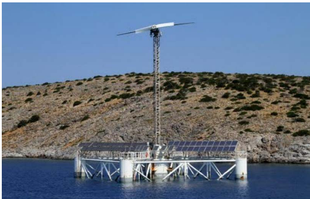
Η πλωτή μονάδα αφαλάτωσης-ΑΠΕ «Υδριάδα», εγκατεστημένη στην Ηρακλειά
