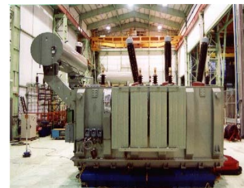
Μετασχηματιστής 150/21 kV, 50 MVA
