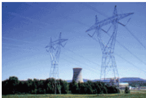
Γραμμή μεταφοράς 400 kV
